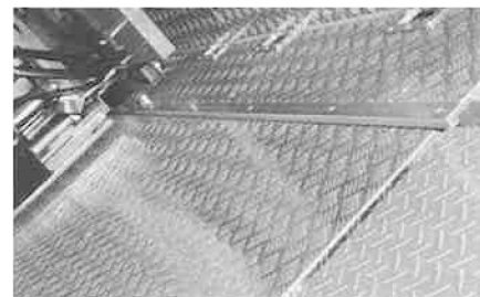
床面は滑りにくく、汚れにくいアルミ縞板貼りに
