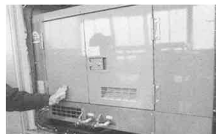
発電機などのレイアウトを見直し、メンテナンス性を高めた
